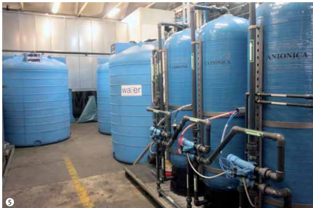
Figura 5: A sinistra il silos di raccolta degli eluati non pericolosi e, a destra, il quadro di controllo per la gestione dei parametri dell'impianto di trattamento acque.
